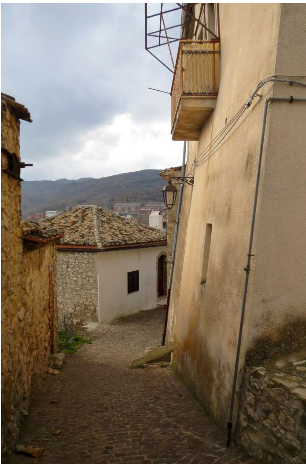
Figura 75. Deliceto. Veduta di uno sperone, elemento di presidio di tipo rigido, costruito sul fronte rivolto a valle attraverso un ringrosso della sezione muraria. L'obiettivo è quello di contrastare le forze spingenti. (G. Ajò, foto gennaio 2018)
