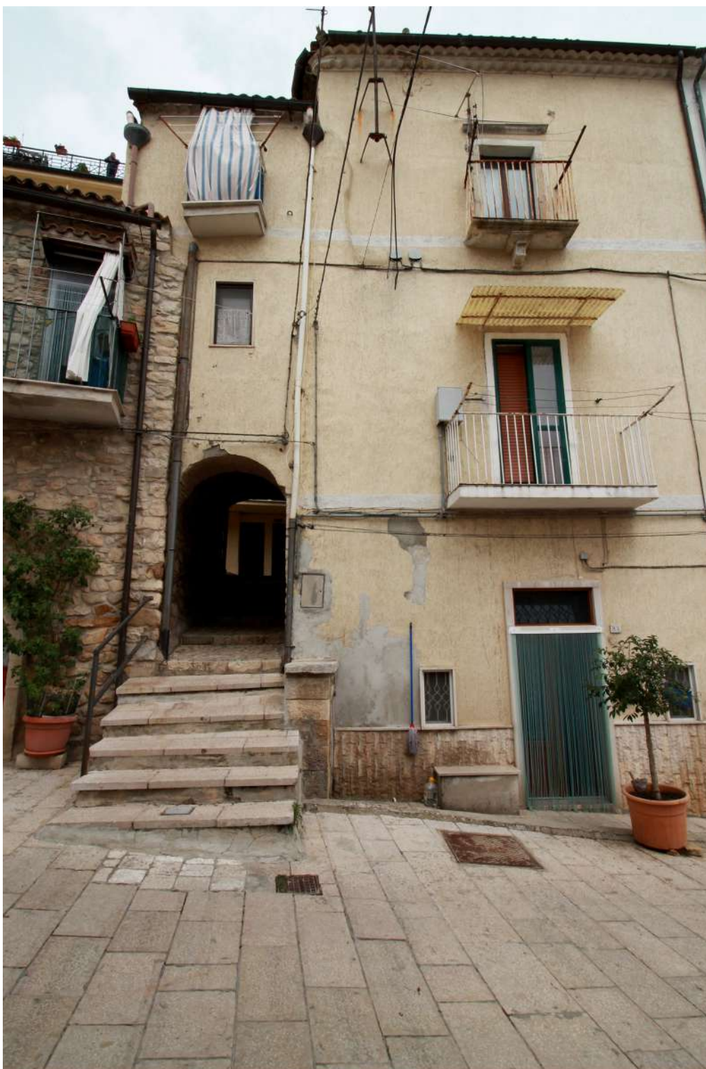
Figura 76. S. Agata di Puglia. Veduta di un elemento di collegamento a volta tra due unità edilizie limitrofe sopra il quale si è sviluppata un'estensione dell'abitazione e sotto cui passa il vicolo. Una buona ammortatura consente una trasmissione "flessibile" degli sforzi da un corpo all'altro. (G. Ajò, foto giugno 2018)
