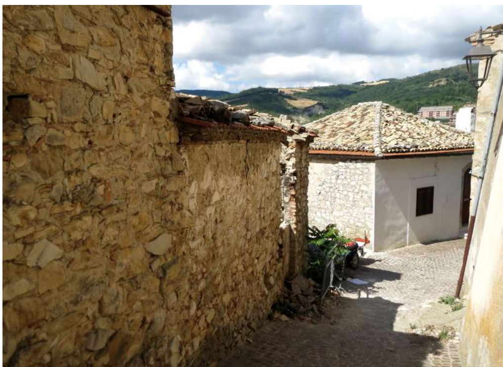
Figura 35. In alto : Deliceto. Lavori di sistemazione del pendio prospiciente l'abitato in seguito ad un evento franoso che ha colpito il paese. (Database ReNDIS, intervento zona Piazza Europa, n. 523/99)
