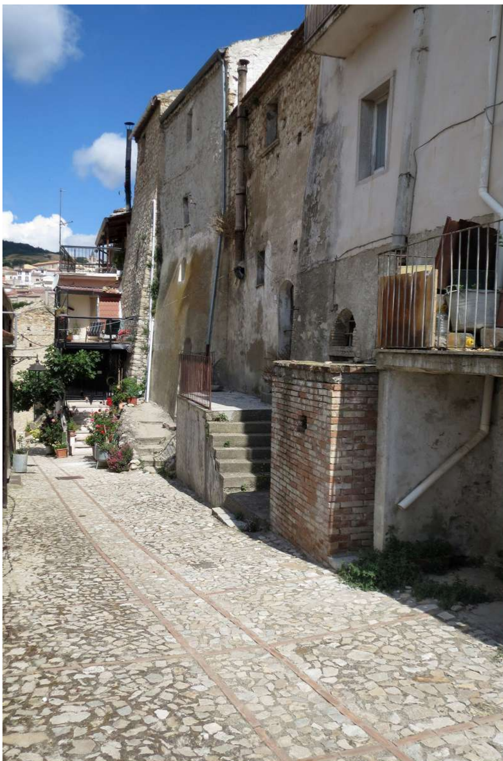
Figura 95. Veduta da via S. Cristoforo di un aggregato parallelo alle curve di livello nel rione Calabria eletto come comparto edilizio di studio. Si susseguono unità-fortezza a schiera e case-torri caratterizzate da un'elevata altezza fuori terra del fronte di valle che definiscono insieme il perimetro difensivo del borgo sul versante meridionale. (G. Ajò, foto giugno 2018)
