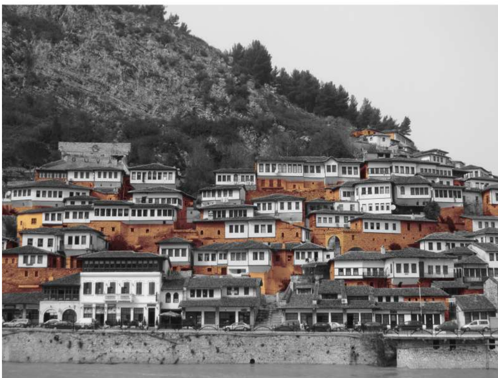
Figura 113. In alto : L'abitato di Mangalem con evidenziazione di un comparto edilizio di studio. Il costruito in forma aggregata e con andamento lineare-convesso dei fronti di valle si distende sul versante ai piedi del castello.
