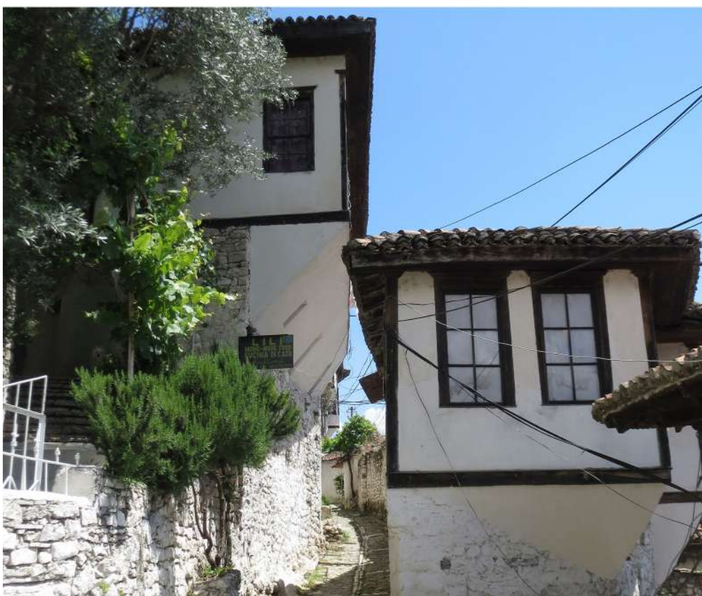
Figura 118. In alto : Il telaio ligneo ( catma ) chiuso da listelli, anch'essi lignei, e poi intonacato a protezione dalle intemperie. (G. Ajò, foto marzo 2018)
