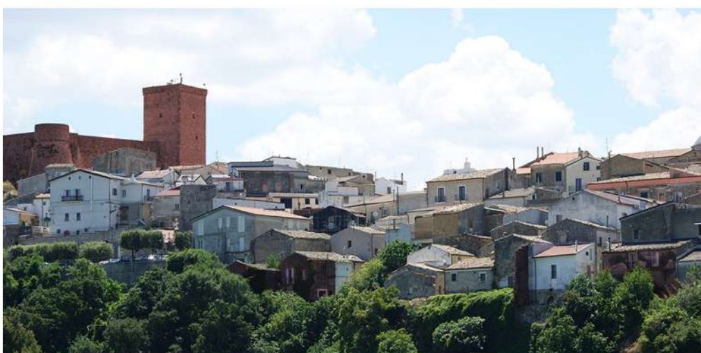
Figura 93. In alto : Veduta del Rione Calabria (colmo) con evidenziazione di elementi del perimetro difensivo. Si notano gli aggregati convessi con notevole altezza fuori terra verso valle. (Laboratorio di Laurea Sicurezza e Identità 2, foto giugno 2018)
