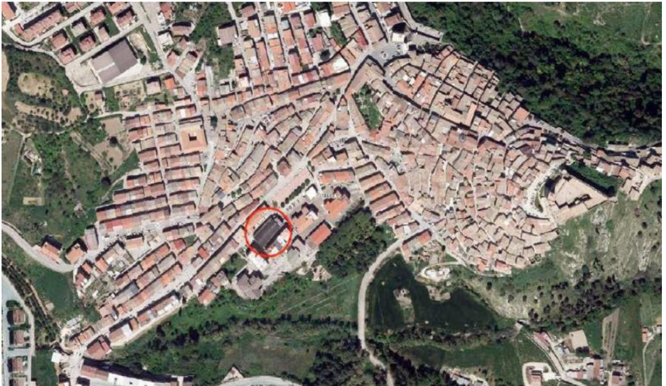
Fig.21 - Mappa fotografica di Deliceto (Italia) con identificazione dell'edificio oggetto di studio, estratta dal Sistema Informativo Territoriale del Comune
