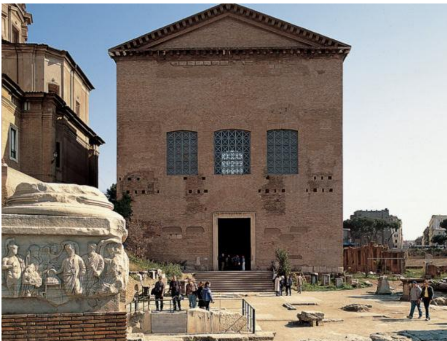
Figure 2.25, 2.26. I percorsi accessibili lungo il Foro Romano, restauro 2014.
