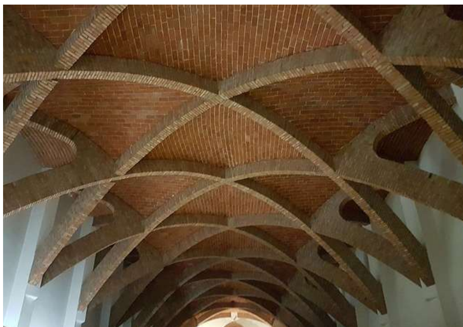
Fig. 11. Nervios estructurales de la calota interna de la cúpula. (Autor, 2025)
