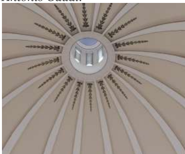
Fig. 11. Nervios estructurales de la calota interna de la cúpula. (Autor, 2025)
