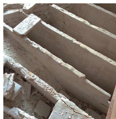
Fig. 4 tabiquillos sobre el trasdós de la bóveda de la capilla de la Lonja de Valencia (en: Zaragozaá Catalán & Marín-Sánchez, 2022).
