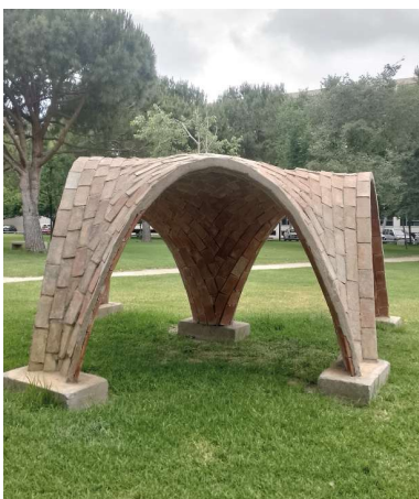
Fig. 2 bóveda tabicada de dos capas (Autor, 2025). proceso constructivo de la bóveda, sin el empleo de cimbras (Tomado de: http://Cargocollective.com ).
