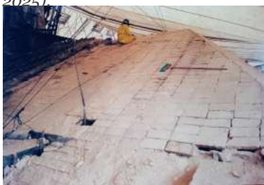
Fig. 9. Tablero de cubierta con aparejo a hueso apoyado sobre tabiquillos (CIVILCO, 1992).
