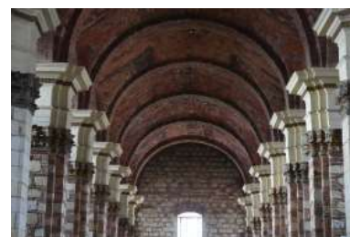
Fig. 36. Variación del arco de imposta en las naves laterales de la Catedral Primada de Bogotá, respecto a las bóvedas de arista de la nave central en Zipaquirá (Autor, 2025).
