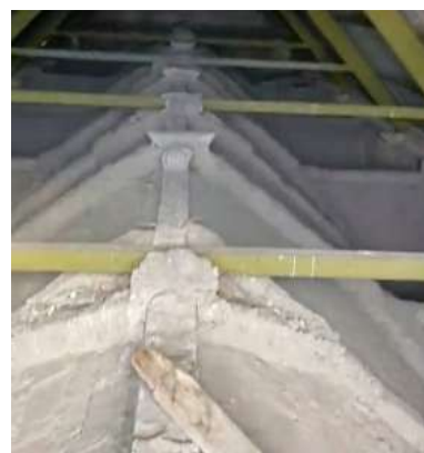
Fig. 28 Ejemplos del uso de bóvedas tabicadas en Santander y Antioquia. (fotografías, Julián Maldonado, 2025, Omar Portela, 2025).
