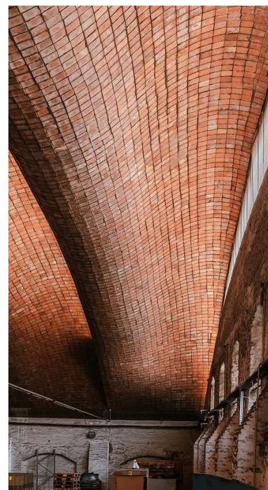
Fig. 24 Deposito Julio Herrera, proyectado por Eladio Dieste y construido en 1978 en Montevideo, Uruguay (tomado de: IG: odyssees_darchitectures, 2025).
