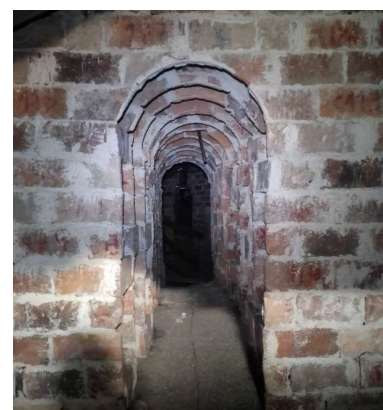
Fig. 5 Callejones a lo largo de los tabiquillos en el trasdós de una bóveda (Autor, 2025).
