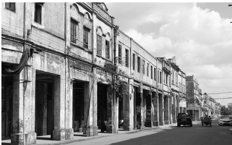
4.50 Fronte articolato da gilou a Kaiping
