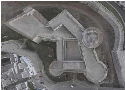
Fig. 4. Otranto (LE), configurazione planimetrica del Castello e del fossato (Baldassarre, et al. , 2018).
