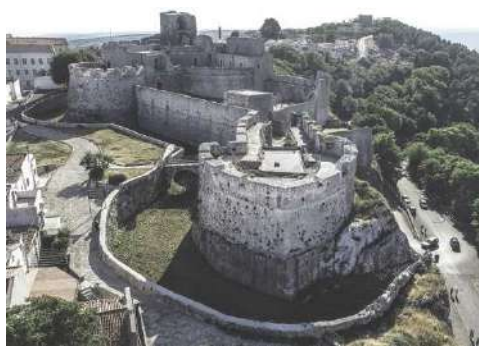
Fig. 6. Monte Sant'Angelo (FG), l'articolato sistema difensivo del Castello (Bruni, et al. , 2019).
