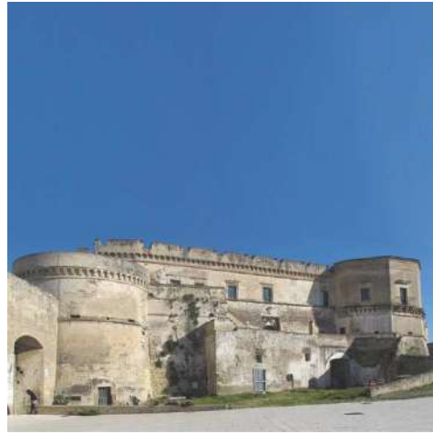
Fig. 2. Massafra (TA), il prospetto sud del Castello (Cardone, et al. , 2013).
