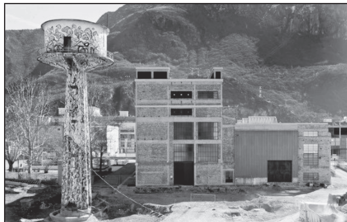
Figura 3 - L'area prima dell'intervento.
