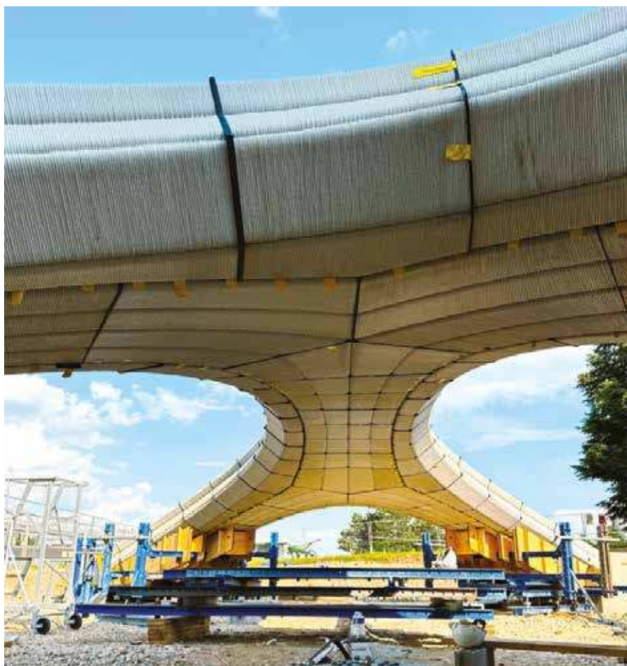
Fig. 79 (a fianco). Phoenix durante la rimozione del sistema di centine (© Block Research Group).
