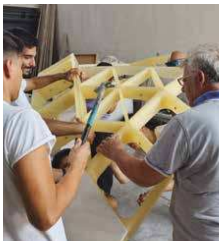
Figg. 184-190 (accanto e alla pagina seguente). La prova di assemblaggio del tripode presso Tarricone Prefabbricati.
