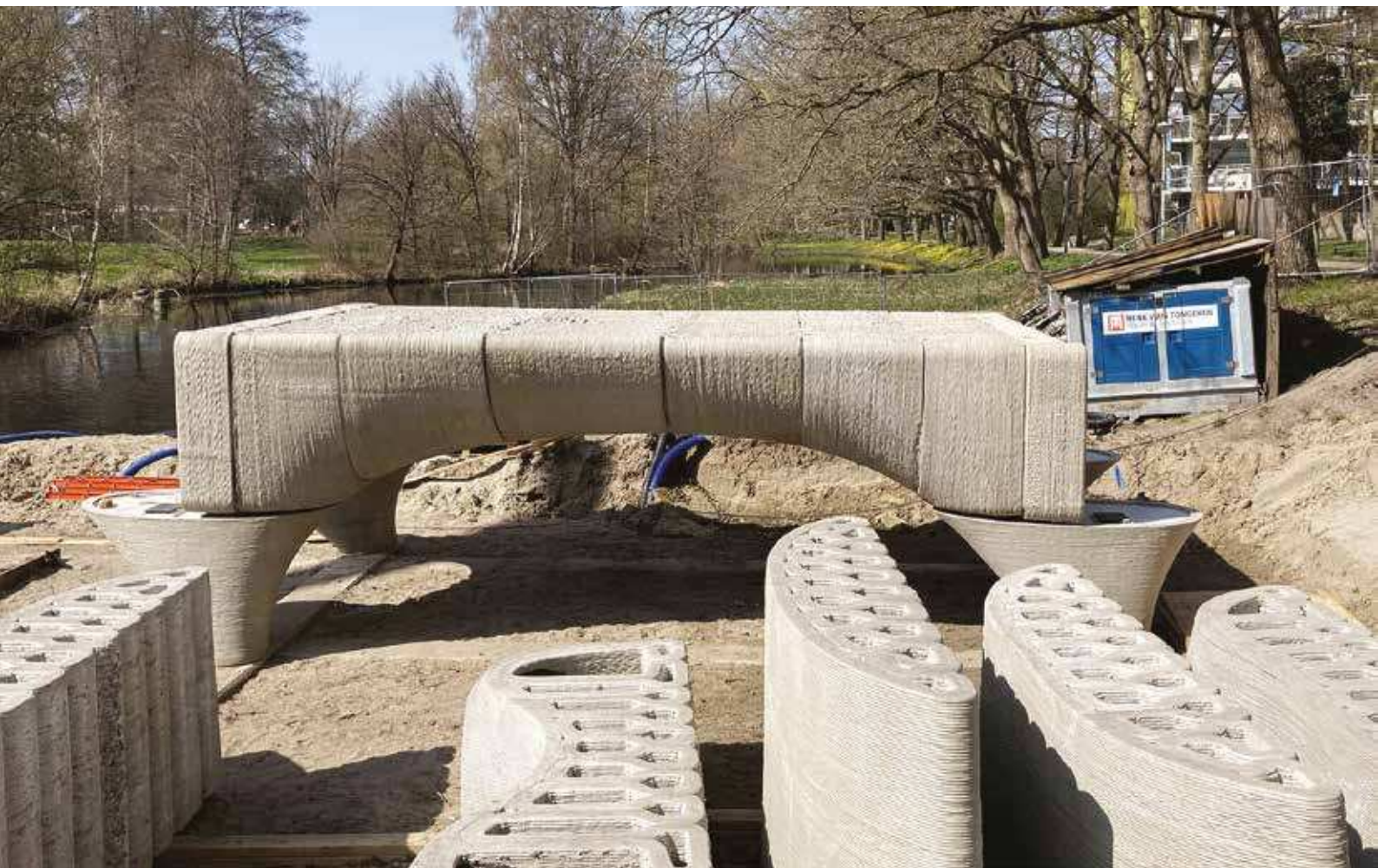
Fig. 51. I blocchi del Nijmegen Bridge sul cantiere, durante la fase di assemblaggio (© Studio Michiel van der Kley).
