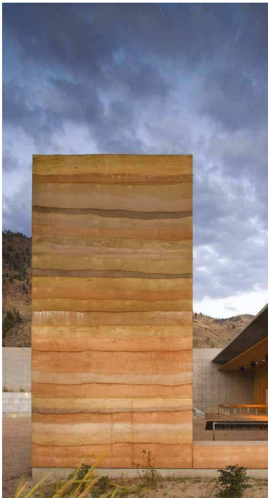
Fig. 21. Il Nk'Mip Desert Cultural Centre a Osoyoos (Canada), progettato dallo studio DIALOG e realizzato in terra con la tecnica del pisé (© Nic Lehoux Photography).
