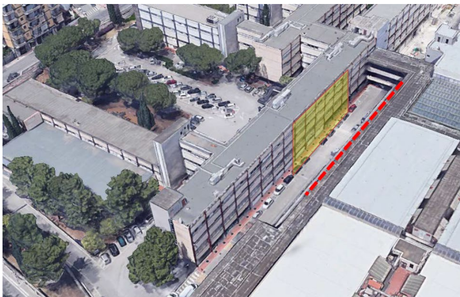
Figura 13 – parete oggetto di ripresa (in giallo), traiettoria seguita per il rilievo fotogrammetrico in rosso (fonte: GoogleMaps)
