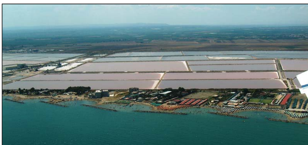
Figura 14– Costruzione di barriere frangiflutti in prossimità del porto di Margherita di Savoia. Fonte: Caldara et al. , 2006.
