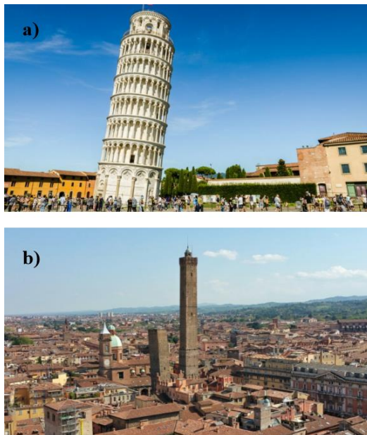
Fig. 1. 1 – a) The Pisa Tower and b) the Bologna Towers: Torre degli Asinelli and Torre della Garisenda.
