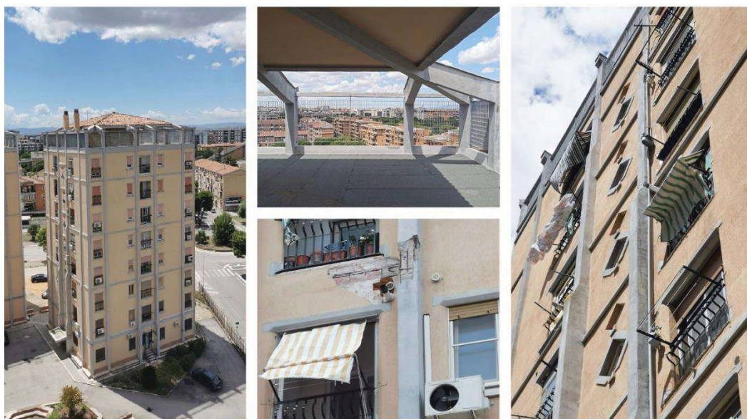
Fig. 60 - Fotografie del complesso ISES di Foggia scattate durante il sopralluogo effettuato ad aprile 2024.
