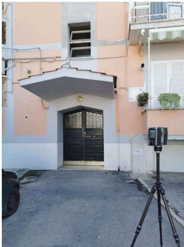
Fig. 67 - Operazioni di rilievo laser scanner presso il quartiere INA-Casa di Cerignola.
