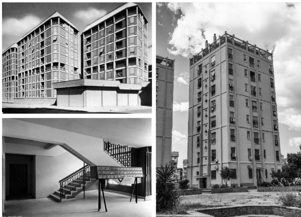
Fig. 4 – Sulla sinistra le Torri INA-Assicurazioni di Via Etiopia a Roma (DiAC, Censimento delle architetture italiane dal 1945 ad oggi), sulla destra gli Alloggi ISES di Via Smaldone a Foggia.
