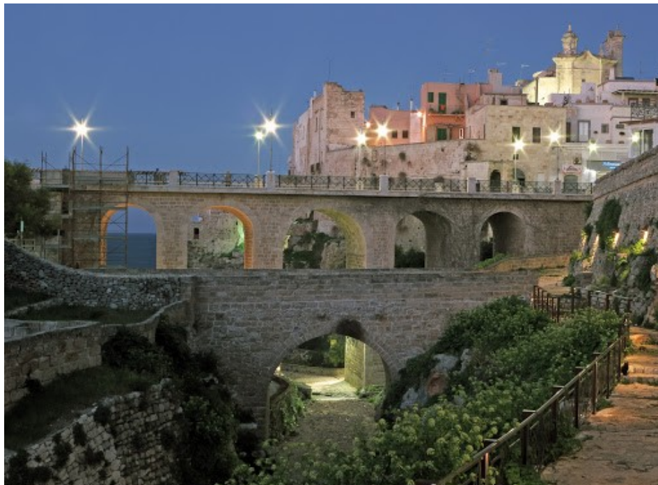
Figura 5.6: Prospetto sud del ponte e ponte romano
