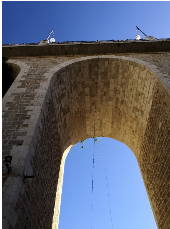
Figura 5.10: Cavi a due conduttori collegano gli accelerometri alla postazione di lavoro posizionata sotto l'arco più grande
