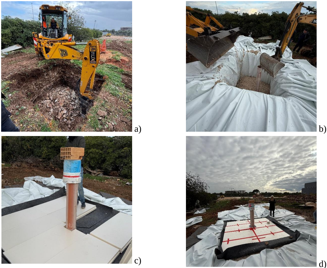
Figura.44 - Fasi realizzative dell'ambiente sotterraneo superficiale.
