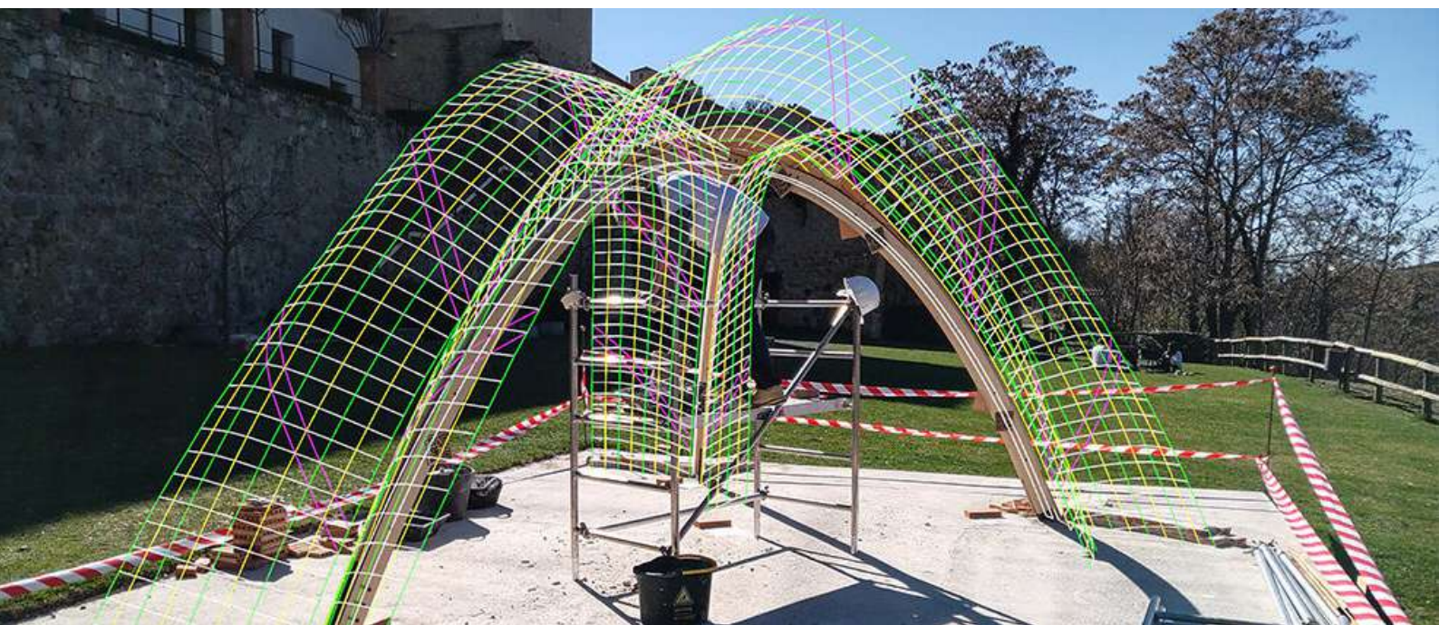
Fig. 36. Visualizzazione a fil di ferro del padiglione InnixAR costruito presso il campus dell'IE University a Segovia. Foto di Wesam Al Asali.
