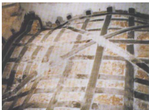
Refuerzos de bóvedas mediante PFR
