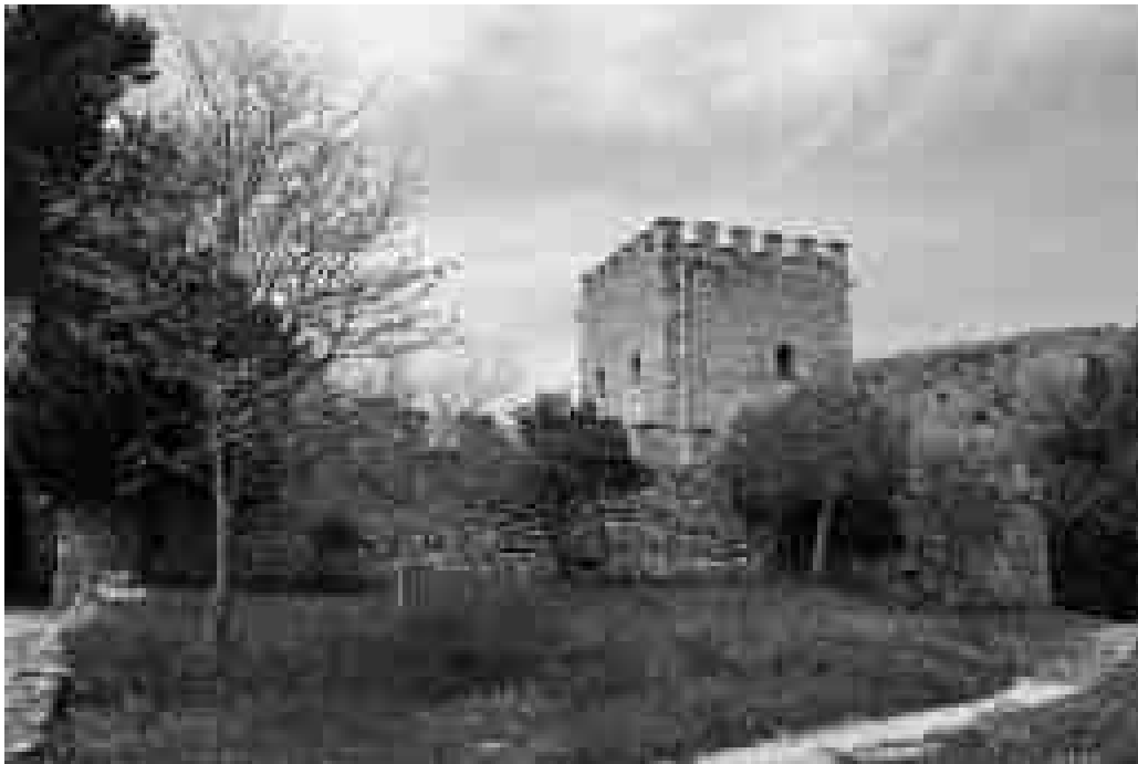
Fig. 20. Butrinto. Castello veneziano, prospetto orientale. Stato attuale (foto F. Gotta 2015).
