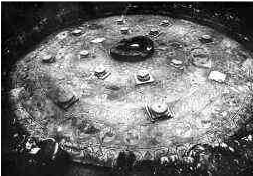
Fig. 1. Butrinto. Battistero, fase precedente al rimontaggio dei fusti di colonne rinvenuti in crollo sul pavimento musivo (da UGOLINI 1937).
