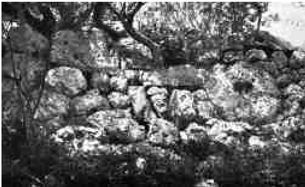
Fig. 5. Calivò. Tratto delle mura di cinta (da UGOLINI 1937).
