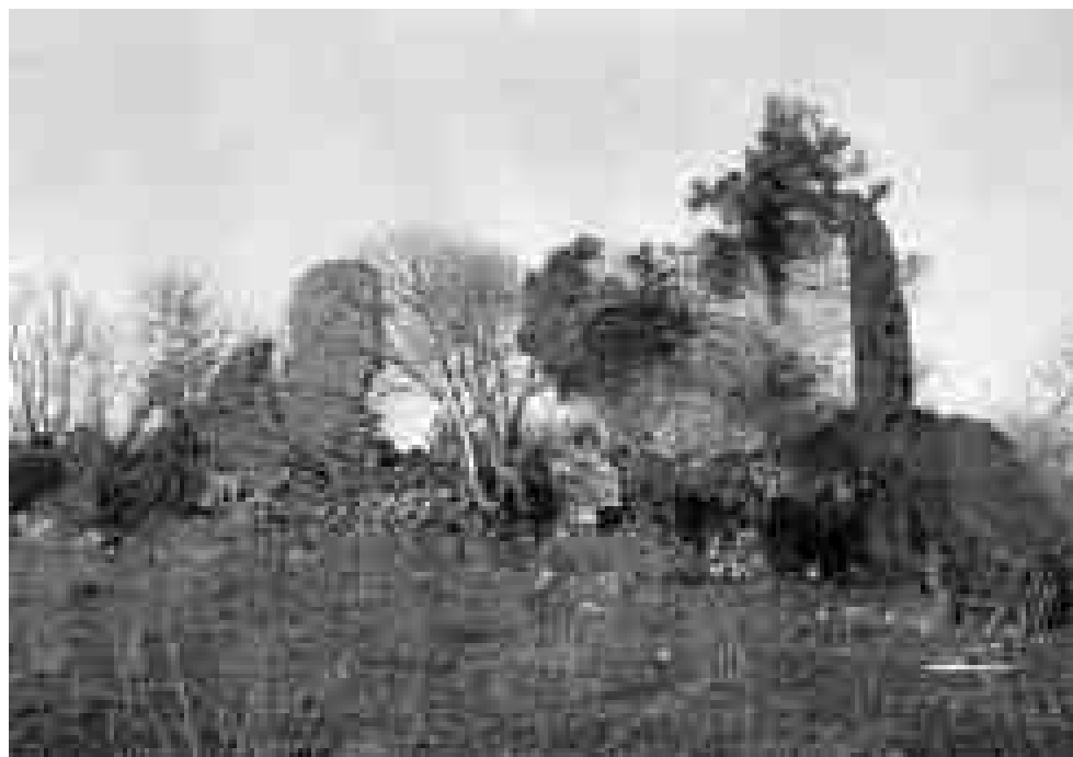
Fig. 8. Butrinto. Castello veneziano, lato orientale. Stato precedente all'avvio delle operazioni di restauro (cortesia Archivio Istituto di Archeologia di Tirana).
