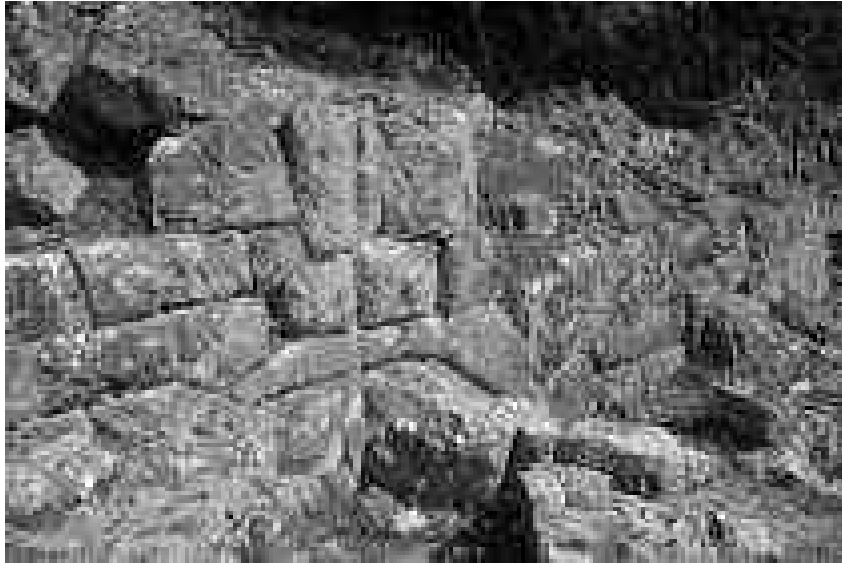
Fig. 8a. Butrinto. Cinta muraria a metà costa del colle, tratto di mura in opera poligonale (foto F. Giannella).
