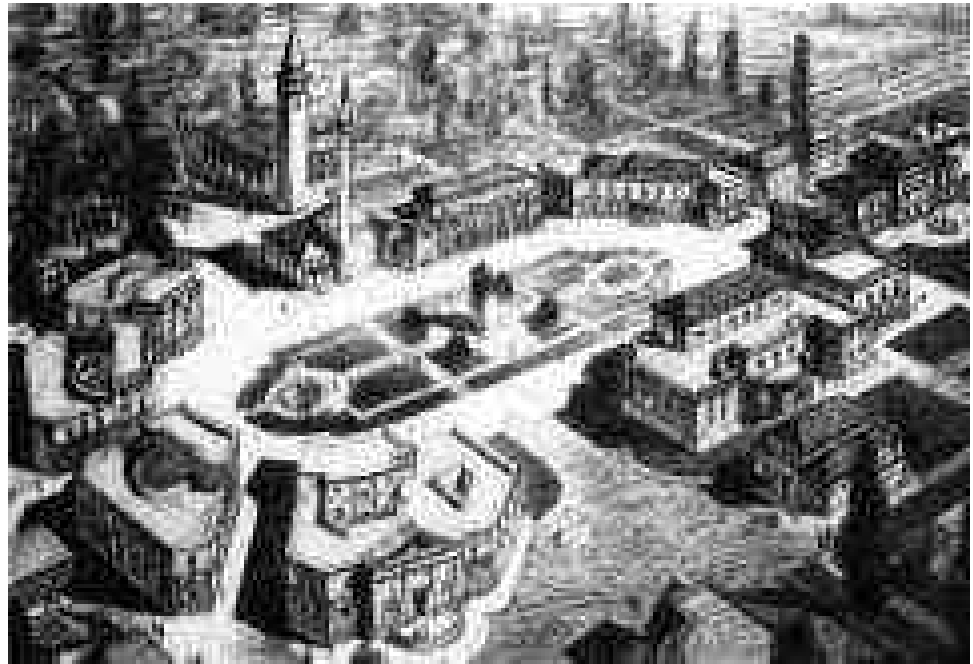
Fig. 3. Florestano Di Fausto. Tirana, sistemazione di Piazza Scanderbeg con i nuovi edifici pubblici, 1930 (da BIANCALE 1932).
