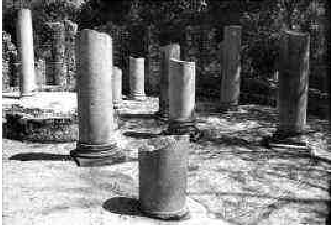
Fig. 14. Butrinto. Il Battistero, dettaglio delle colonne e della pavimentazione al termine del restauro, 1940 (cortesia Franco Tagliarini).
