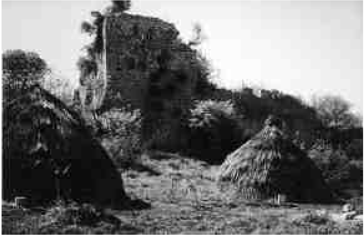
Fig. 13. Butrinto. Castello veneziano, prospetto settentrionale. Stato precedente all'avvio delle operazioni di restauro (cortesia famiglia Taddei).
