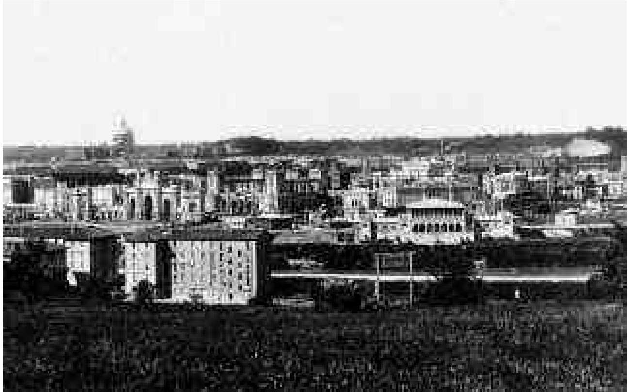
Fig. 13. Roma. Panorama dei padiglioni della Esposizione nel quartiere Prati. Sulla destra la mole della Nave Romana (da LAMBLASE 2003).
