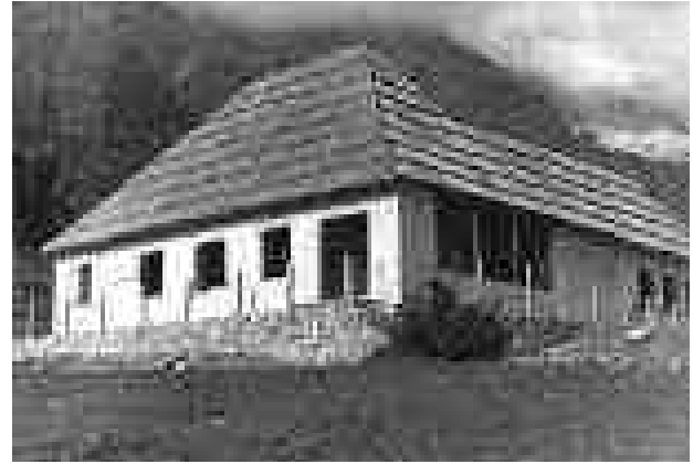
Fig.14. Val di Thethi. Rifugio della Direzione del Turismo (cortesia Franco Tagliarini).
