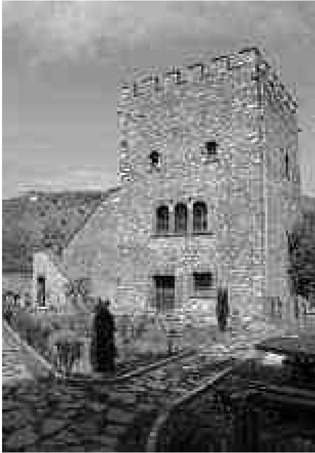
Fig. 15. Butrinto. Castello veneziano, torre principale. Prospetto meridionale (foto F. Gotta 2015).
