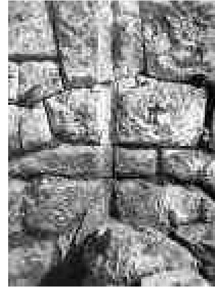
Fig. 8b. Butrinto. Cinta muraria a metà costa del colle, tratto di mura in opera poligonale. Particolare (foto F. Giannella).
