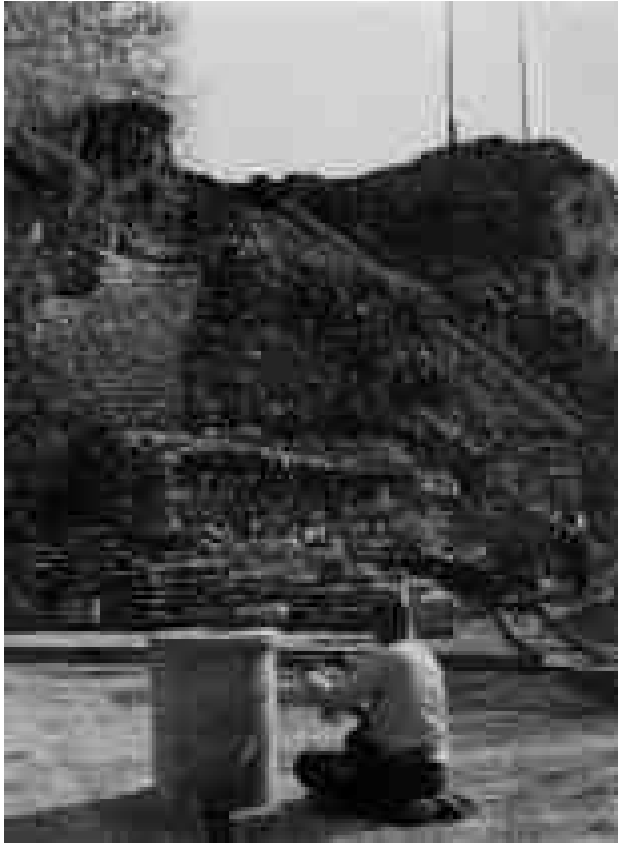
Fig. 33. Butrinto, castello veneziano. Le fortificazioni settentrionali durante le operazioni di ricostruzione (cortesia famiglia Taddei).
