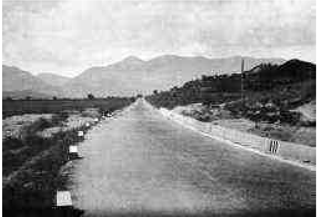
Fig. 14. Albania. L'autostrada Tirana-Durazzo (da MASSANI 1940).
