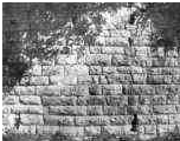
Fig. 11. Butrinto. Cinta muraria bassa, lato settentrionale (da UGOLINI 1942).
