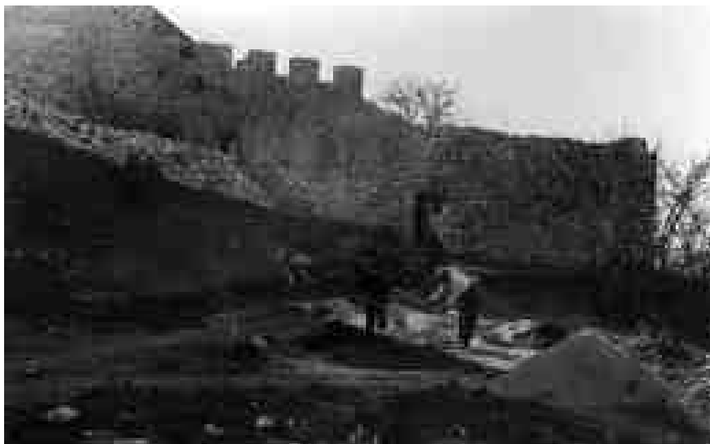
Fig. 35. Butrinto, castello veneziano. Le fortificazioni settentrionali durante le operazioni di ricostruzione (cortesia famiglia Taddei).
