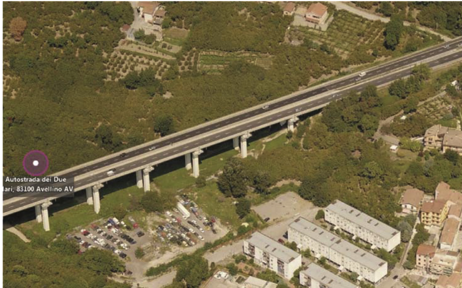
Fig. 4 – ‘Lenze Pezze di Valle’ viaduct.
