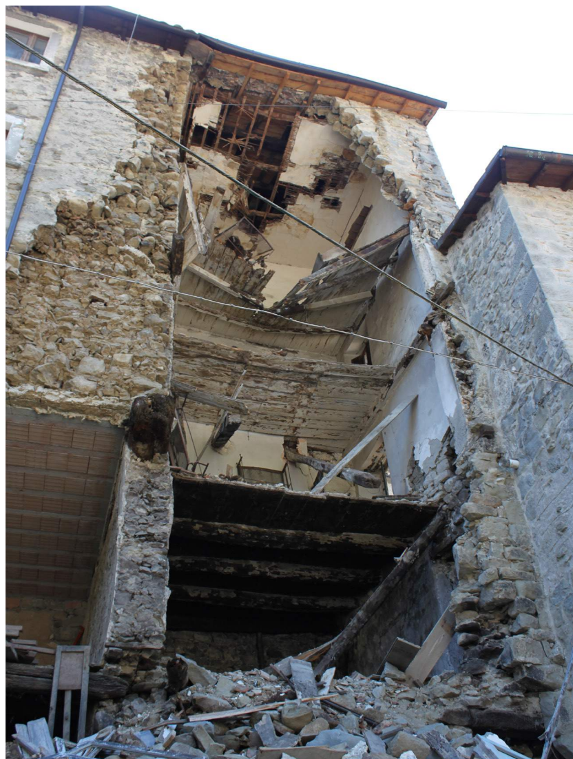
Fig. 2 - Quintodecimo: esempio di casa a schiera a sigola cella, a più livelli, quasi completamente distrutta a seguito del terremoto del 24 Agosto 2016. Quintodecimo: example of a multi-story single cell row-house almost completely destroyed after the earthquake of the 24th August 2016.
