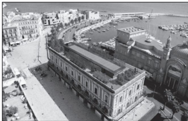
Figura 3 - L'edificio dell'ex Mercato del Pesce - situazione di progetto. A destra il Teatro Margherita
