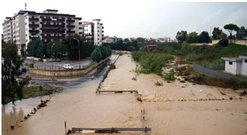
Figure 2.6 Overflow Canale Patri
