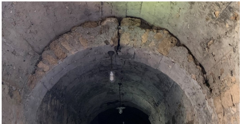
Fig. 31 - Frattura di volta a botte e arco conseguente a sovraccarichi derivati da costruzioni successive, Anagni (Roma)
