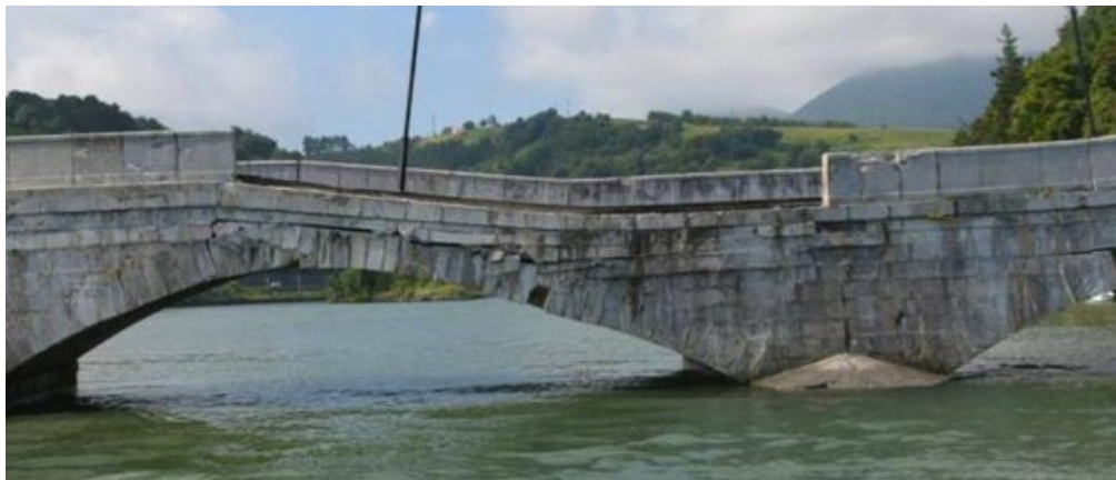
Fig. 30 - Meccanismo di frattura per cedimento del pilone nel Ponte Deba, Paesi Baschi, Spagna
