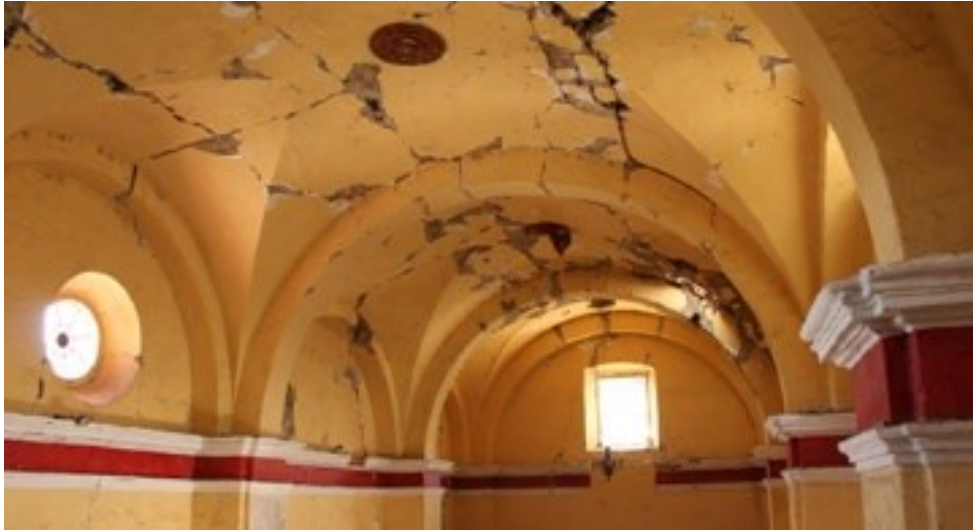
Fig. 32 - Fratture nella volta della Parrocchia ed Ex Convento Di Santiago Apostolo, Jiutepec (Messico) conseguenti al terremoto del 2017
