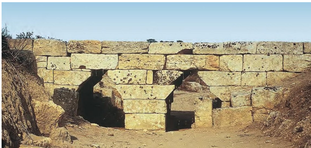
Fig. 6 - Ponte a doppio pseudoarco, Selinunte (VI-V sec. a.C.) [22]
