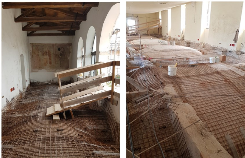
Fig. 2 - Tecniche di rinforzo nel Monastero di San Basilio a L'Aquila, dopo il terremoto del 6 Aprile 2009
