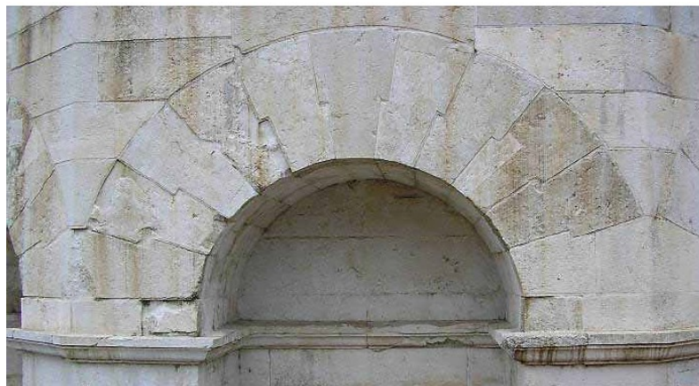
Fig. 13 - Esempio di arco con giunti a scalino nel Mausoleo di Teodorico a Ravenna (VI secolo d.C.)
