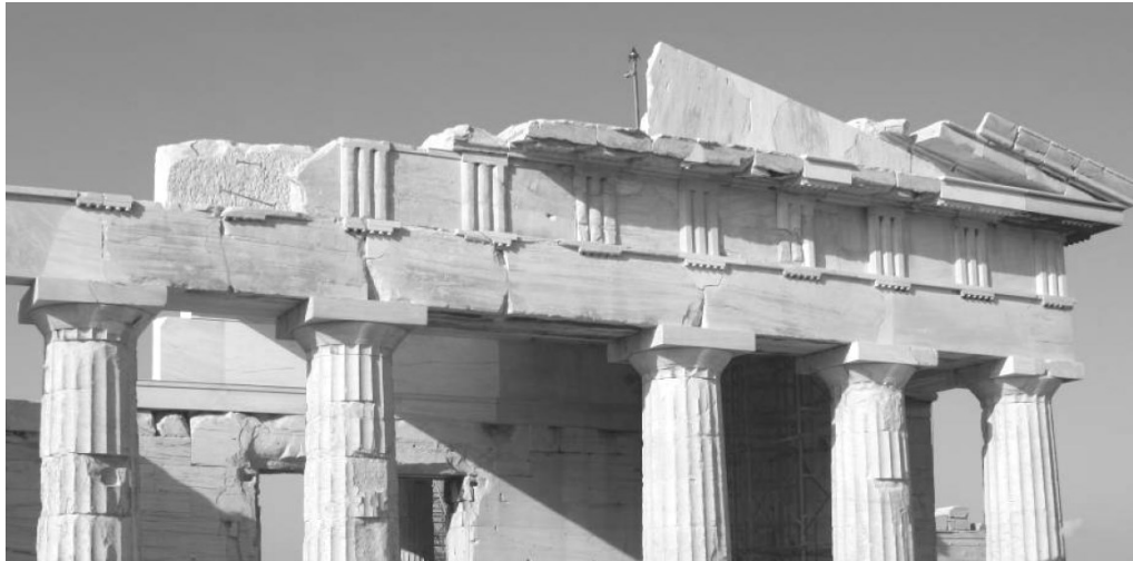
Fig. 3 - Sistema trilitico, Propilei, Acropoli di Atene (V sec a.C.)
