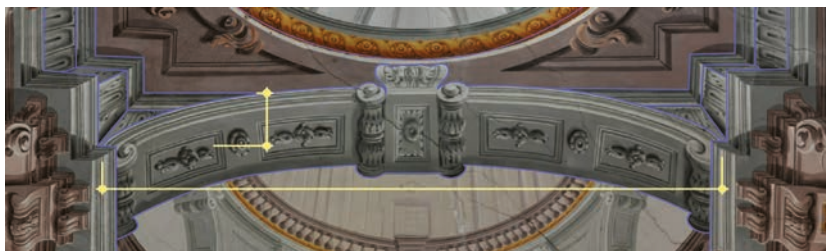
Fig. 4. Arcone di sostegno del secondo solaio e trabeazione modanata a cavetto decorato.
