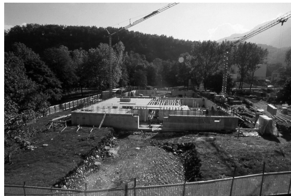
49. Sala Polivanete, Losone, la costruzione dello zoccolo (archivio Studio Vacchini )
