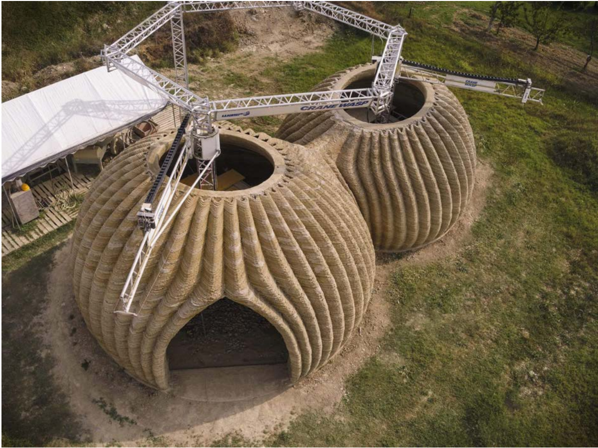
Il processo realizzativo tramite la stampante CRANE © WASP
