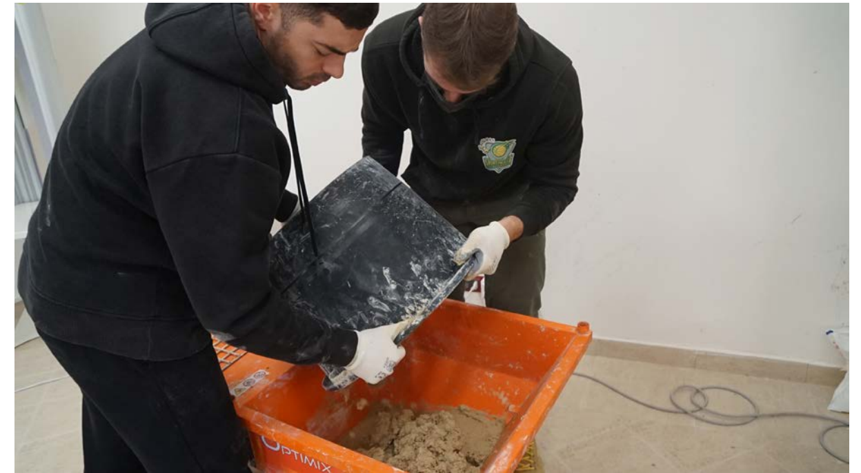
Fasi di carico dell'impasto nel sistema di pompaggio
