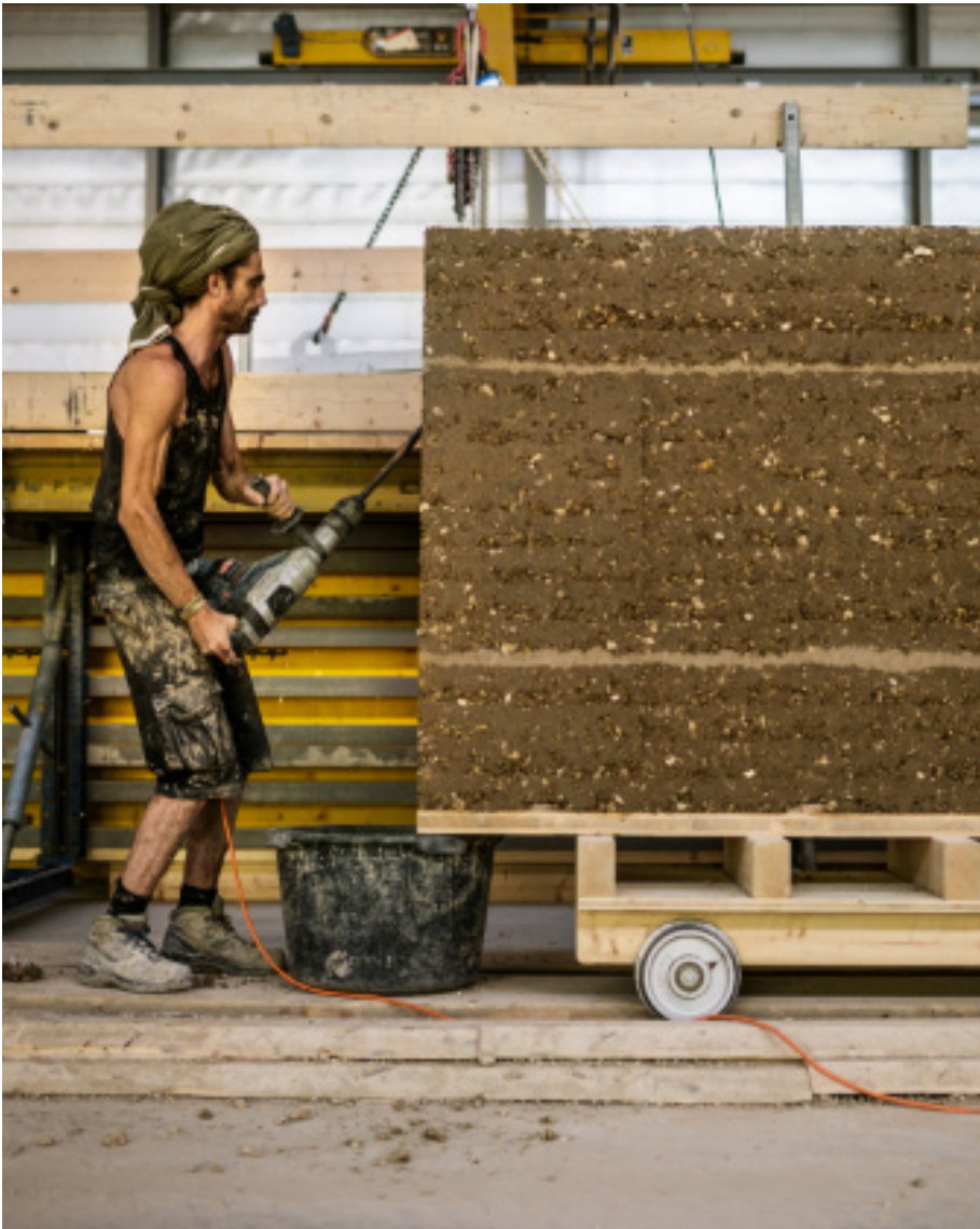
▲ La realizzazione di un muro il pisé in opera con l'ausilio di vibrocompattatori
