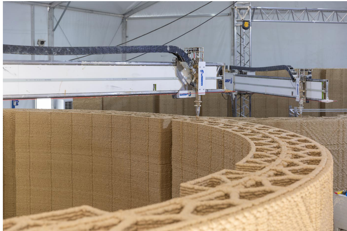
Il processo realizzativo tramite la stampante CRANE © WASP
