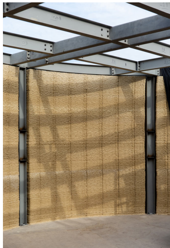
Il processo realizzativo tramite la stampante CRANE © WASP
