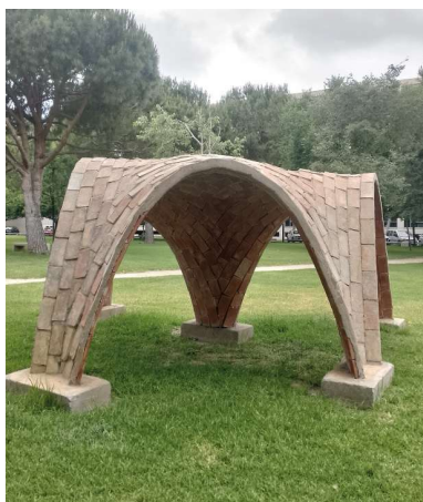
Fig. 2 bóveda tabicada de dos capas (Autor, 2025). proceso constructivo de la bóveda, sin el empleo de cimbras (Tomado de: http://Cargocollective.com ).
