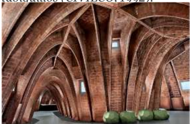
Fig. 10. Costillas intradosales de las cubiertas de la Pedrera. Antonio Gaudí.
