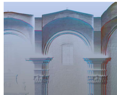
Fig. 27. Comparación entre los planos de levantamiento y la realidad documentada en la sección de la Catedral Diocesana en Zipaquirá (Autor, 2025).
